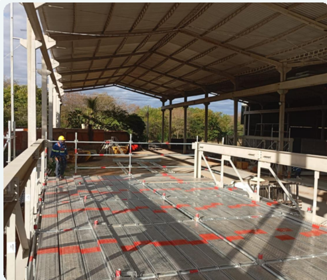
Plataformas e estruturas
